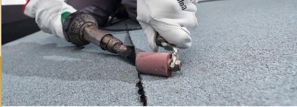
**IKO MONO ALPA 3000 AR/F** est une solution d'étanchéité monocouche soudable directement sur **ancienne étanchéité bitumineuse apparente** ou sur **laine minérale nue**.
