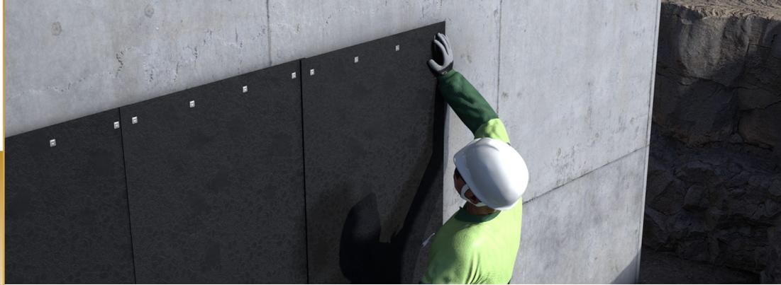
IKO MONO PAROIS ALPA 3000 F/F est mis en œuvre par thermosoudage à la flamme sans EIF sur maçonnerie ou béton banché
