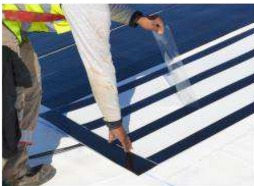
Etape 1 : retirer le film pelable des bandes Butyle
