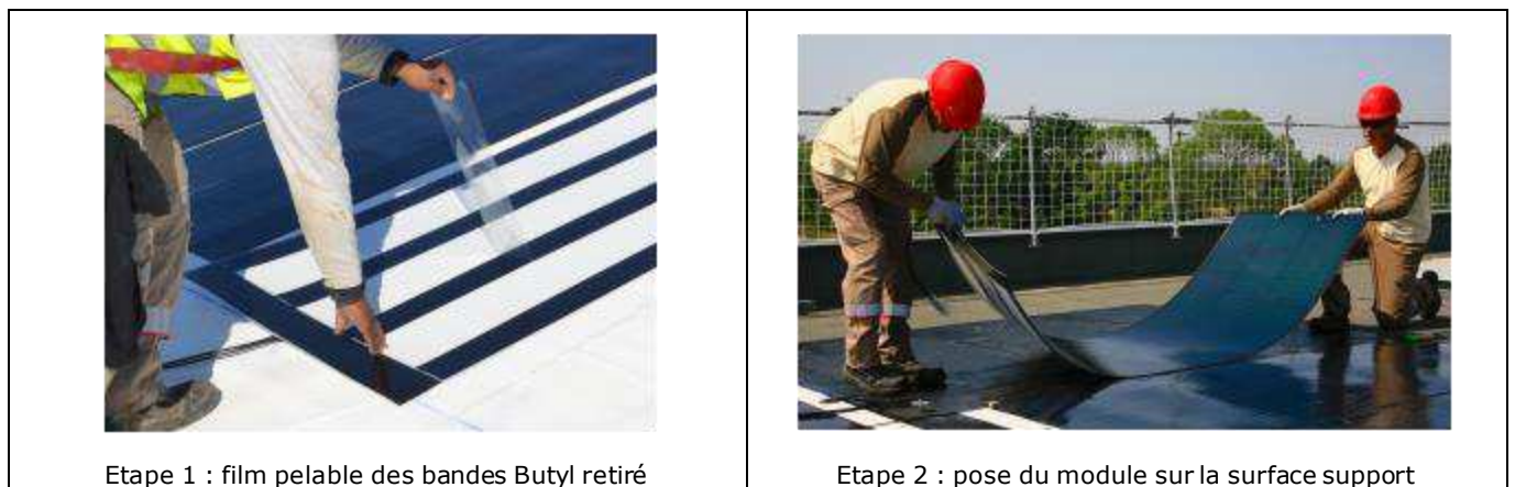
Figure 9 - Mise en œuvre du module photovoltaïque souple EXCEL®SOLAR
