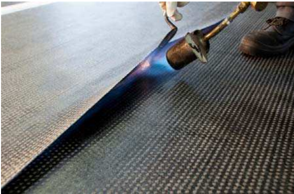
Figures 5 – Étapes de mise en œuvre des membranes SPF
